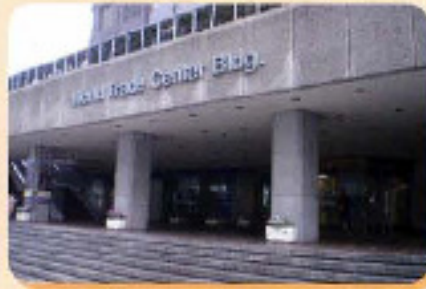
▲世界貿易センタービル
